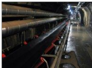
Maanalaiset tilat ja tunnelit
