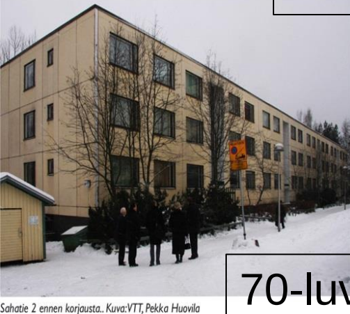
Sahatie 2 ennen korjausta.. Kuva: VTT, Pekka Huovila
