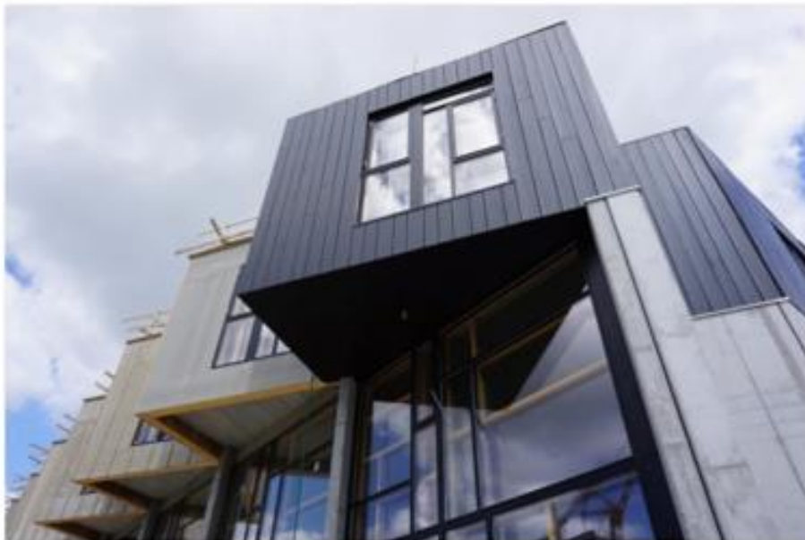
Lendager Groupin Upcycle studios -asunnoissa on käytetty kierrätettyjä ikkunoita, puuosia ja betonia. kuva: Lendager Group
